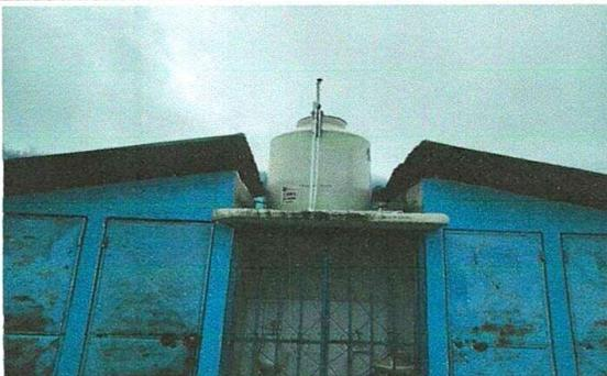
Foto 5: Sustitución de accesorios de depósito de agua y reemplazo de rotoplas negro por un beige que estaba en bodega
